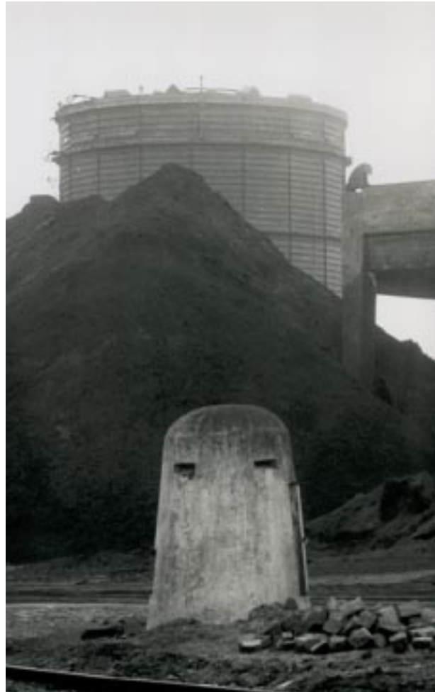
Einmann-Bunker auf dem Werksgelände während des Zweiten Weltkrieges
