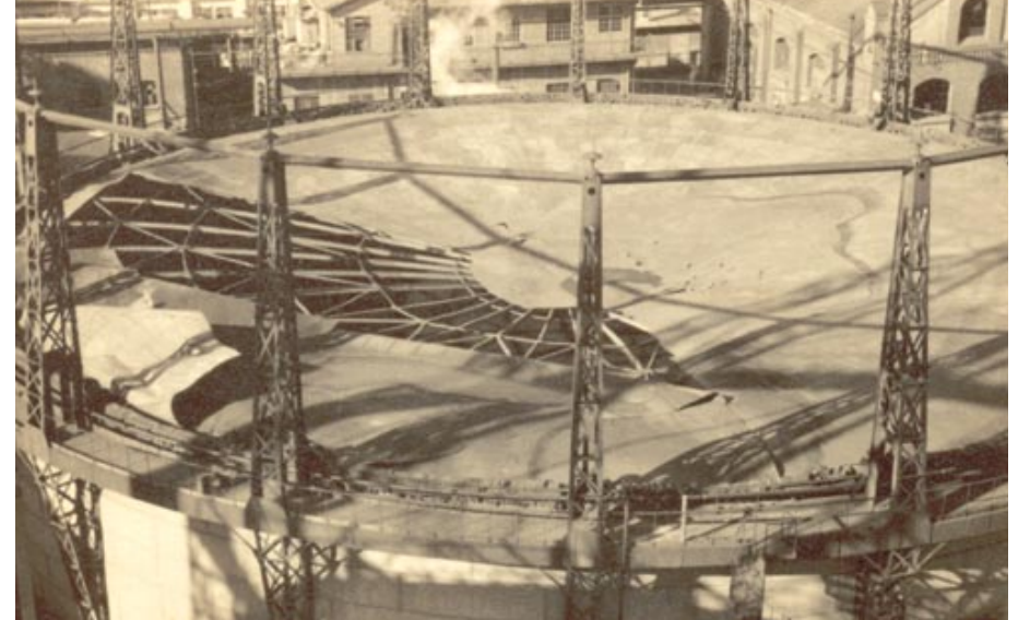
Beschädigter Gasbehälter an der Frankfurter Straße nach dem Luftangriff vom 23./24. September 1943
