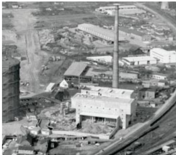
Blick auf den 1948 errichteten Gasometer und das neue Müllheizkraftwerk, 1967
