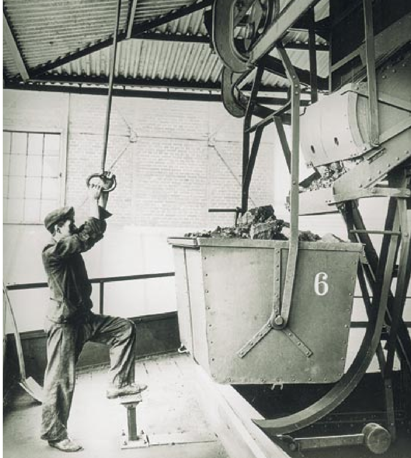
Kohletransportanlage im alten Gaswerk
