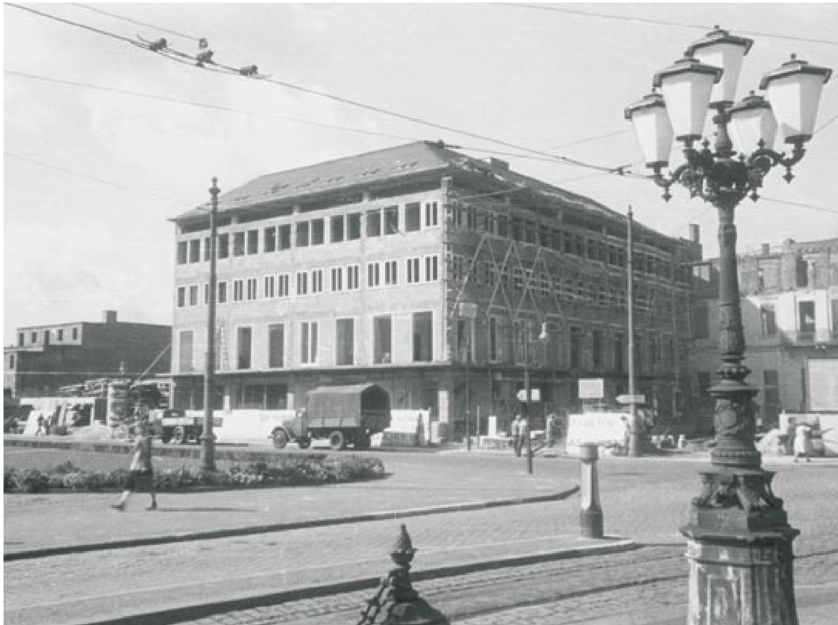
Neubau am Luisenplatz (1950), in dem sich auch das Beratungszentrum der Südhessischen Gas und Wasser AG befand
