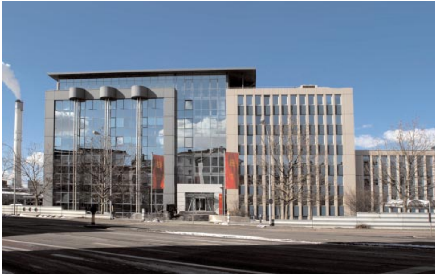
Hauptverwaltung der HEAG Südheissische Energie AG (HSE) in der Frankfurter Straße
