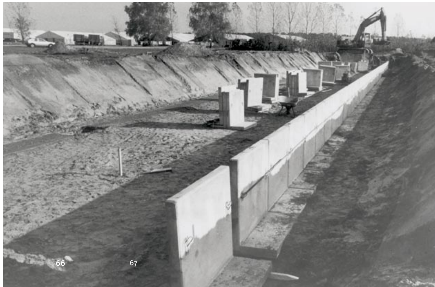
Bau der Sickerschlitzes für die Rheinwasser- versickerung bei Griesheim, November 1988
