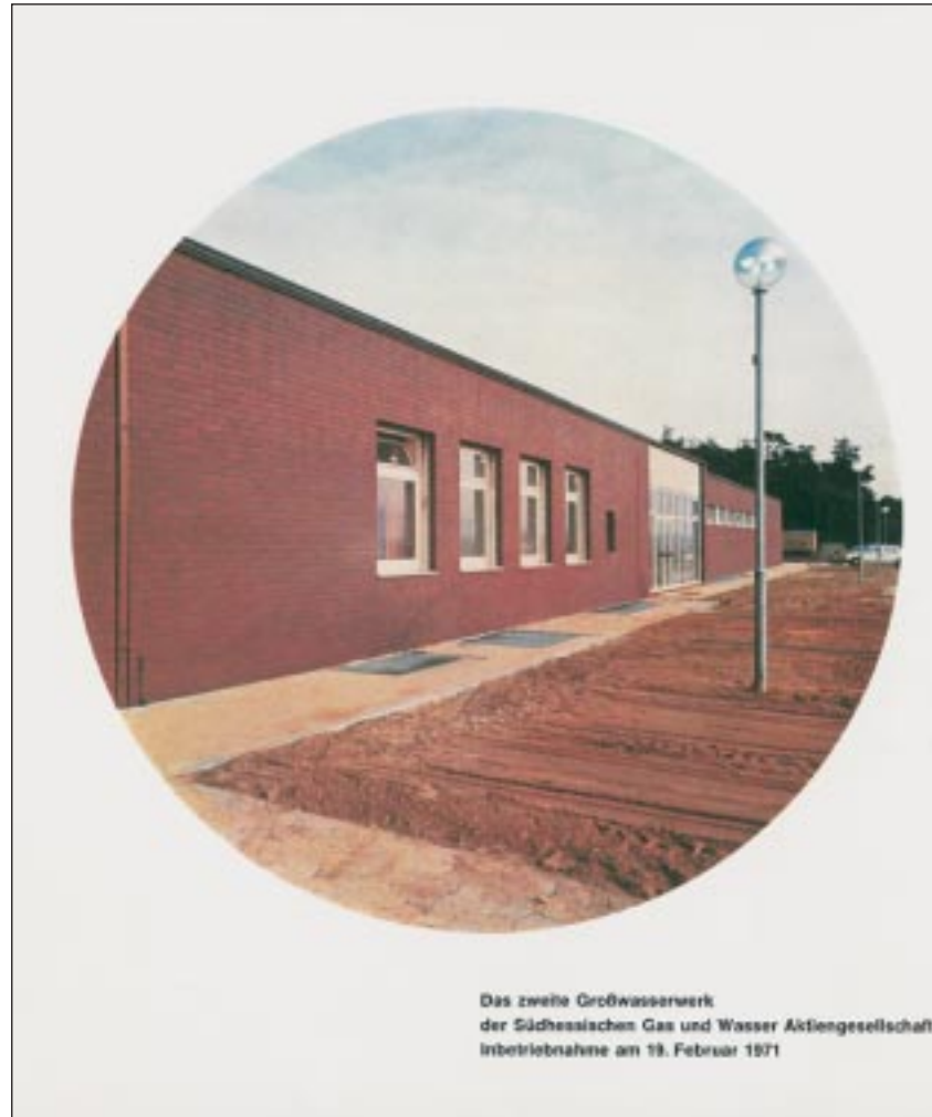
Das zweite Großwasserwerk der Südhessischen Gas und Wasser AG
